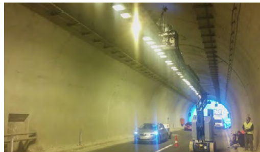
Manipulador móvil para inspección de túneles de transporte por carretera de hormigón sin corte del tráfico rodante (RoboSpect, UC3M/Robotnik)
