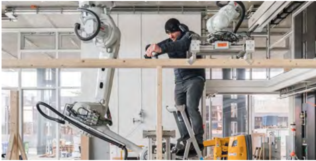
Colaboración Humano-Robot en la construcción de estructuras de madera (World Economic Forum/ETH)
