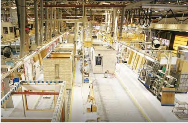
Factoría robotizada de prefabricación de módulos completos para edificios residencial (Sekisui Heim)
