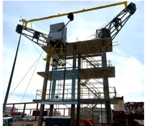
El robot Hephaestus controlado por cables para la instalación de módulos del muro cortina (Tecnalia, coordinador)
